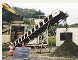
造粒固化機で汚泥を改良し、盛土としてリサイクルを行う。
