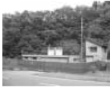
高柳町山中浄水場
